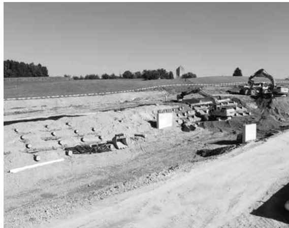
Bachoffenlegung in Gossau SG: Hangsicherung aus Rundholz, erstellt aus eigenem Holz. Foto: P. Schilling
