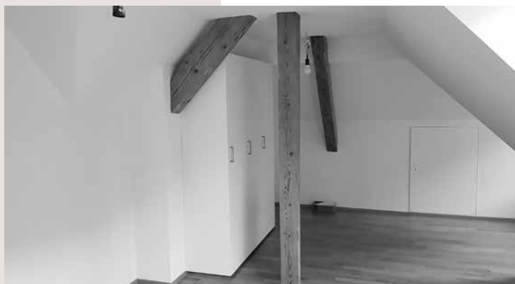
Sanierung Hauswartwohnung Gallusschulhaus.
